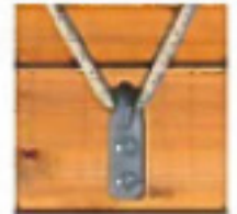
Abbildung der an der Oberfläche vorhandenen Haken
