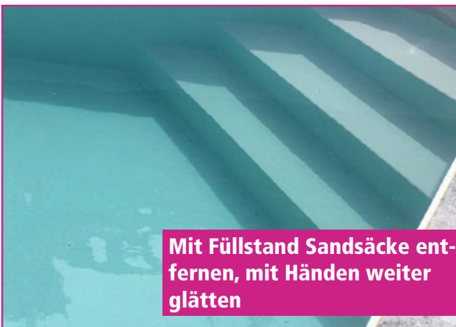
Nach Einrichten der Treppenfolie ausreichend beschweren
