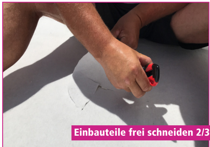
Einbauteile frei schneiden 1/3
