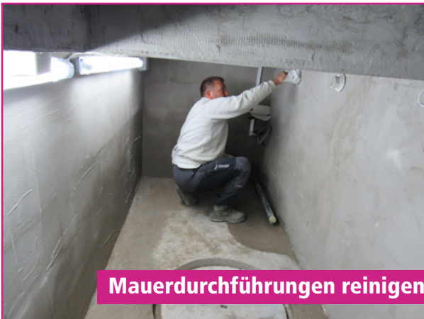
Fittings reinigen vor Ankleben an Mauerdurchführungen
