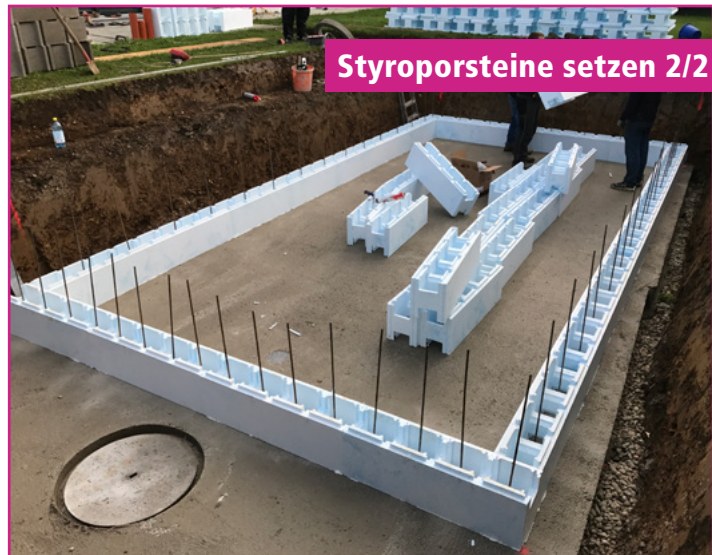
Styroporsteine setzen 1/2
