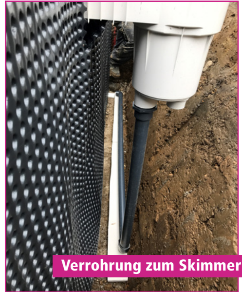
Noppenfolie an Außenseite und Verrohrung über Längsseite
