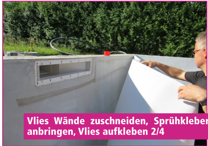
Vlies Wände zuschneiden, Sprühkleber anbringen, Vlies aufkleben 1/4
