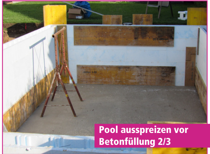
Pool ausspreizen vor Betonfüllung 1/3
