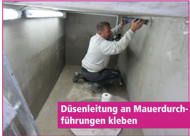
Fittings reinigen vor Ankleben an Mauerdurchführungen
