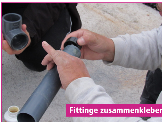
Kleber mit Pinsel auftragen
