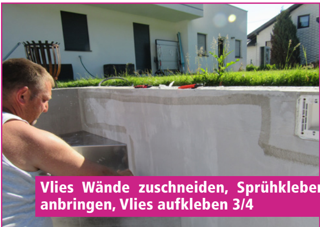
Vlies Wände zuschneiden, Sprühkleber anbringen, Vlies aufkleben 1/4
