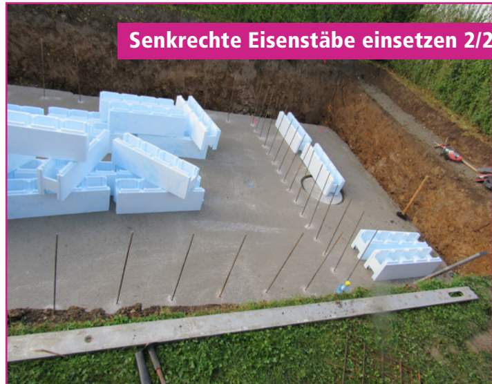
Senkrechte Eisenstäbe einsetzen 1/2
