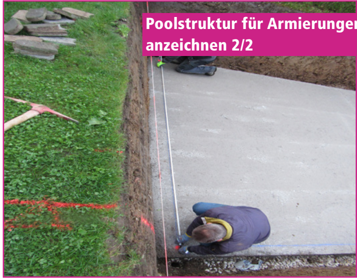
Poolstruktur für Armierungen anzeichnen 1/2
