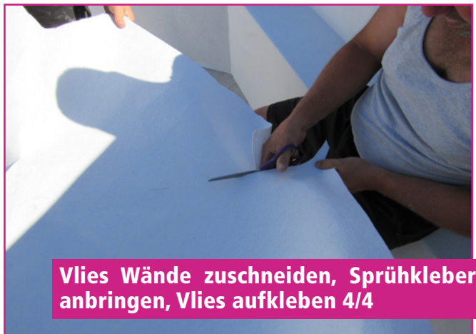
Vlies Wände zuschneiden, Sprühkleber anbringen, Vlies aufkleben 3/4
