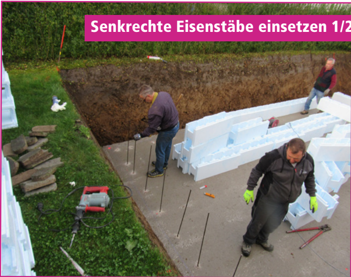
Styroporsteine setzen 1/2
