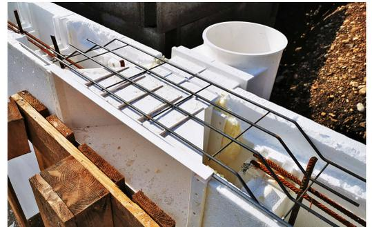
Die Edelstahlverstärkung wird auf 2 Längen der Klemmprofileiste platziert (unmittelbar neben der Einhängeleiste - Ausschnitt im Skimmer).
